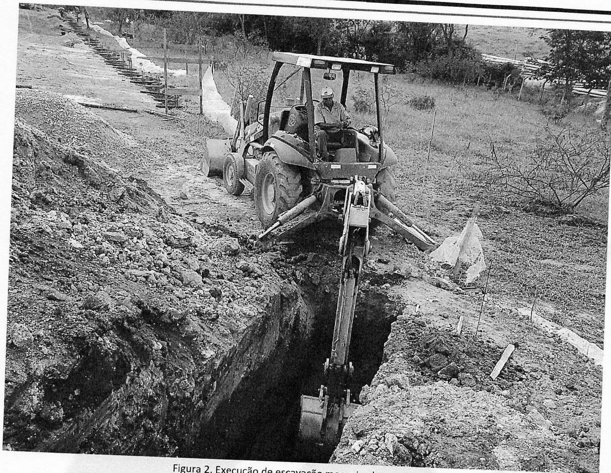
Figura 2. Execução de escavação mecanizada para vala.
