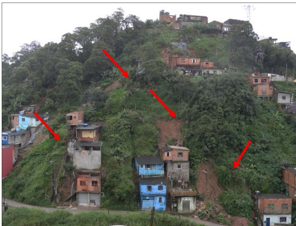
Figura 27 – Trecho da Rua Sergipe, na Vila São João, onde foi registrado um total de 38 moradias em R3 e onze em R4. Esse detalhe mostra um dos trechos, em encosta natural com elevada inclinação e altura, indicando com setas vermelhas as quatro cicatrizes de deslizamento, as quais destruíram parcialmente algumas moradias. Fonte: IPT (2013).
