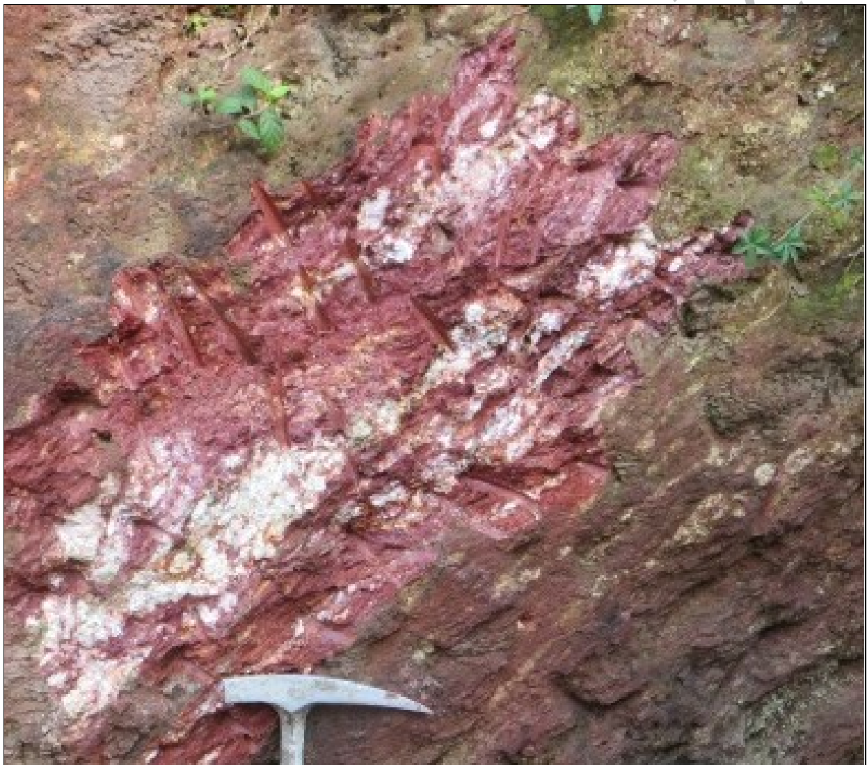
Figura 5 – Foliação milonítica, em zona de movimentação tectônica intensificada, estabelecendo planos de cisalhamento e propiciando maior instabilidade aos taludes. Fonte: arquivo IPT.
