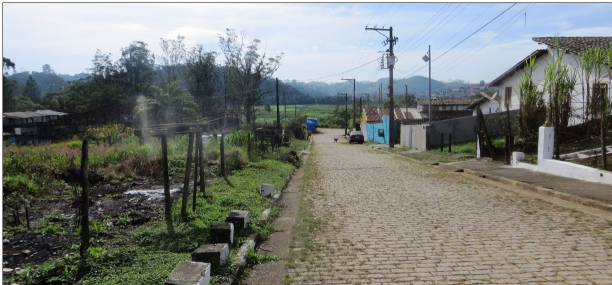
Figura 10 – Exemplo de ocupação de encosta e fundo de vale, com concentração de águas superficiais servidas, alcançando os cursos d'água e degradando os mananciais. Fonte: arquivo IPT.
